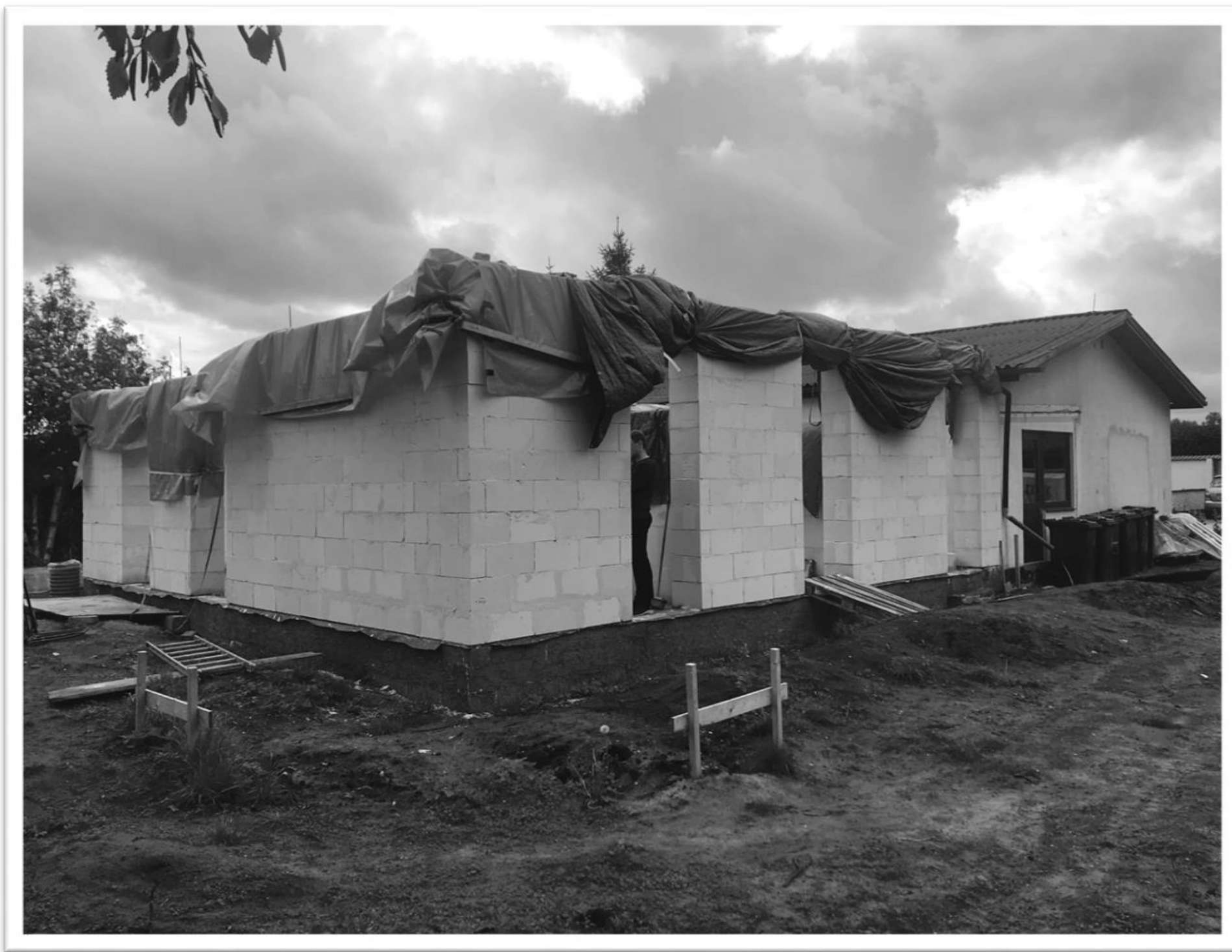
Syd facade - før
