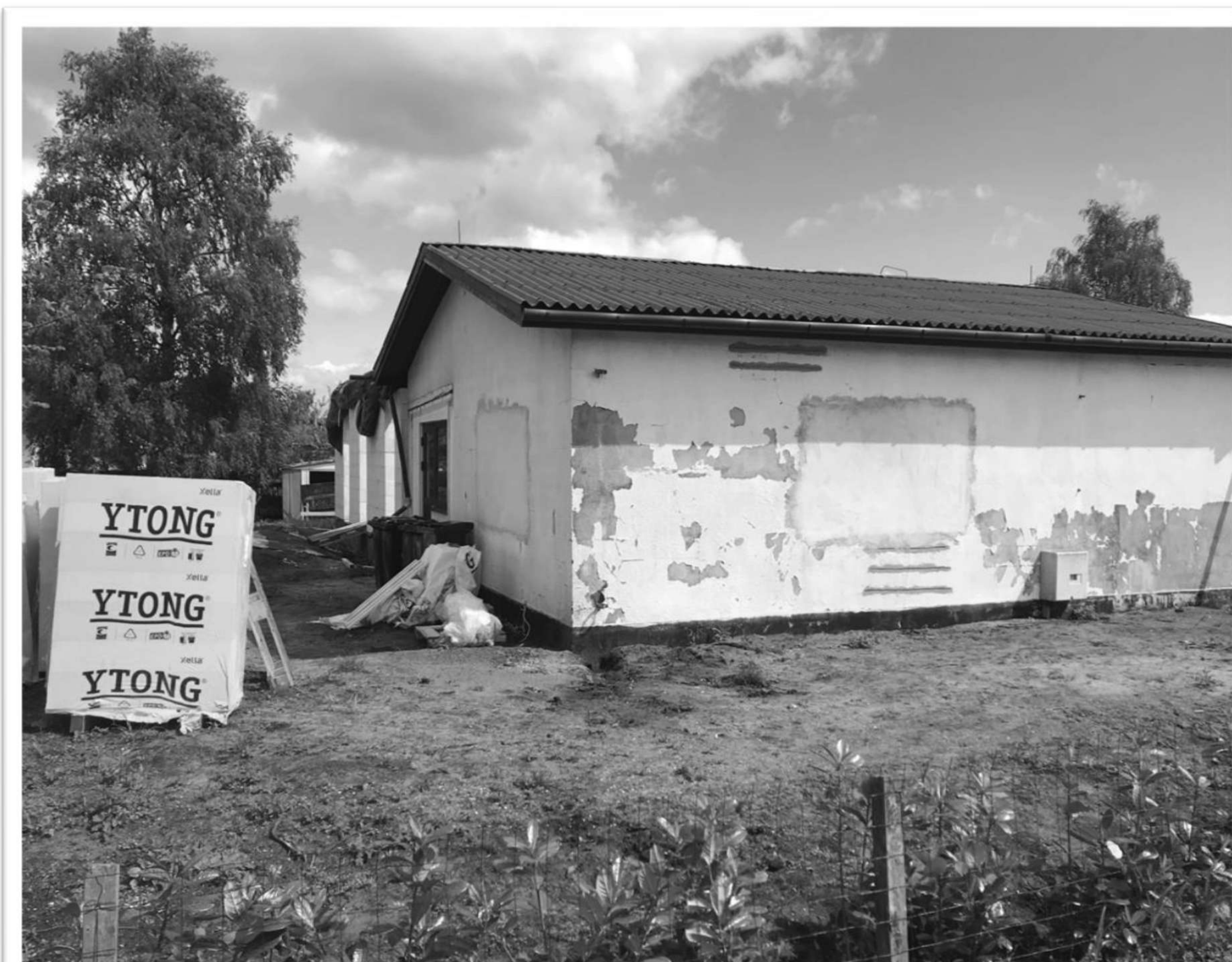
Vest facade - før
